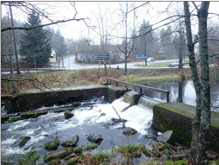
Kakkosenkulma. Betonirakenteiden jäännöksiä ja pato koskessa. Länteen.
