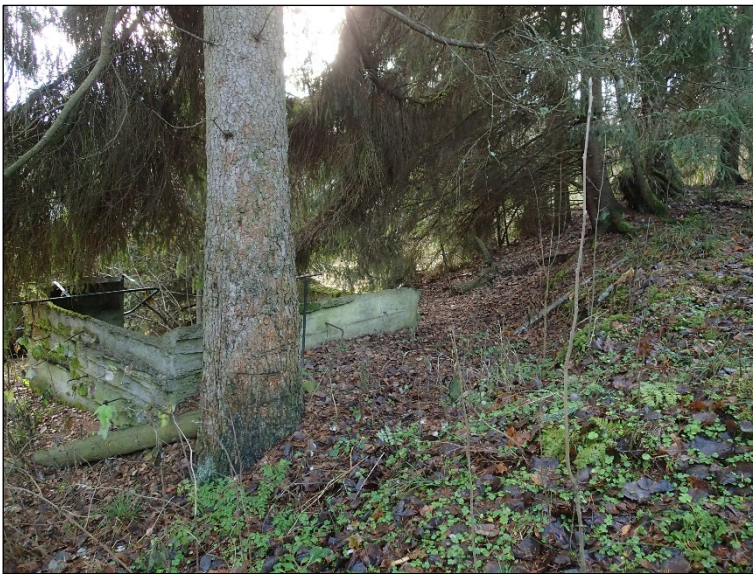
Hyväneula Linnamäki. Itäreunan alarinnettä, jossa betonirakenteen perustus. Etelään.
